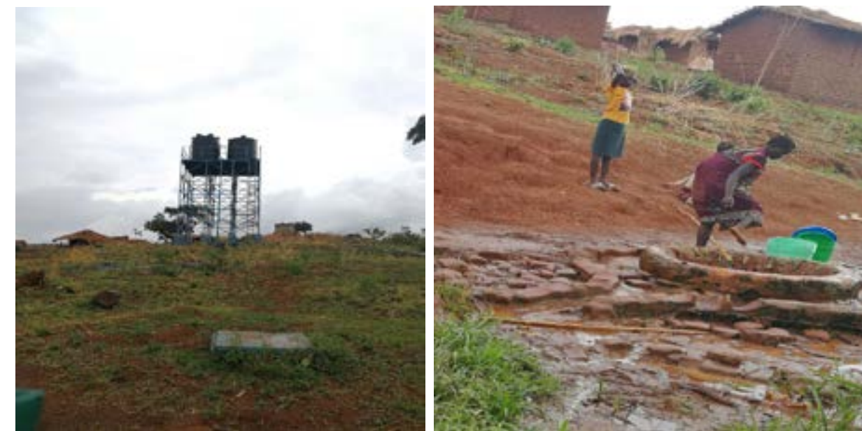
Figura 9: Sistema de abastecimento de água inoperacional; Poço tradicional desprotegido usado pela comunidade e bairros circunvizinhos.
