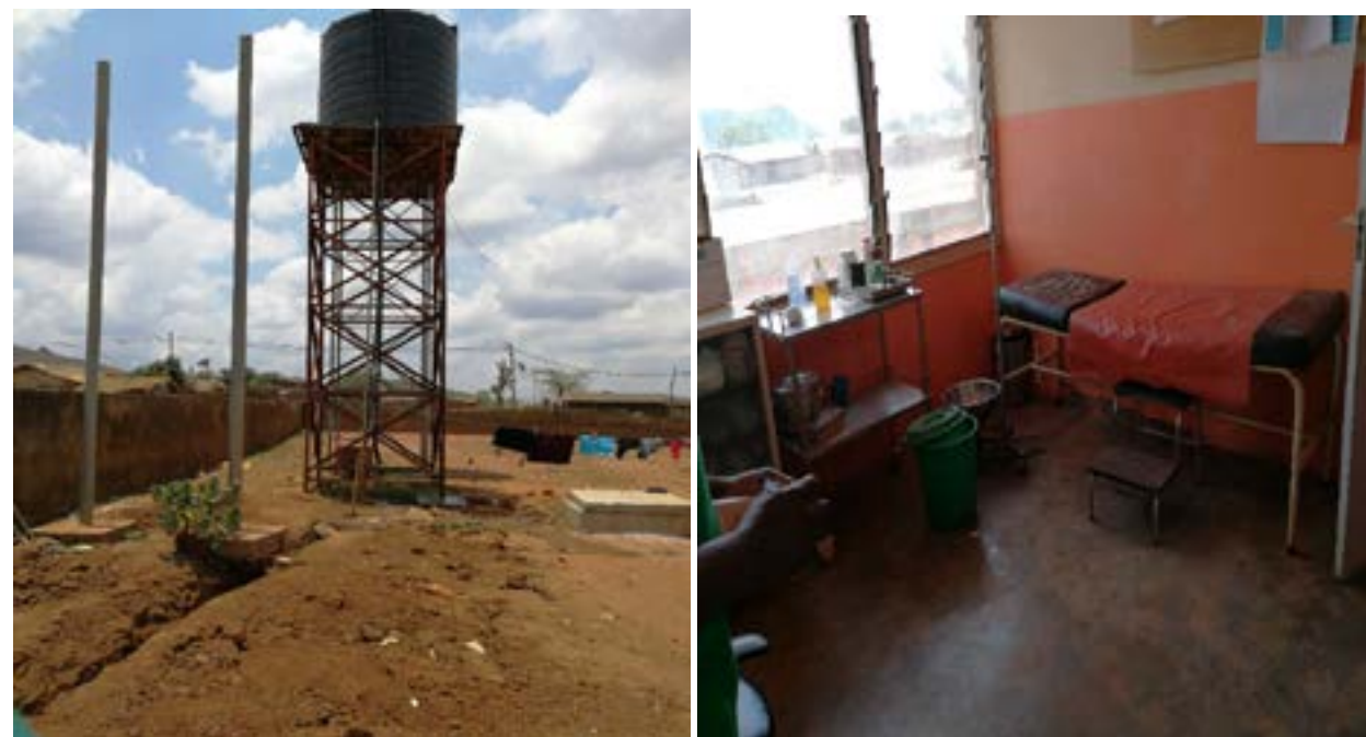
Figura 4: À esquerda sistema de abastecimento de água do CS de Mapaco inoperacional. À direita sala de consultas e de atendimento
