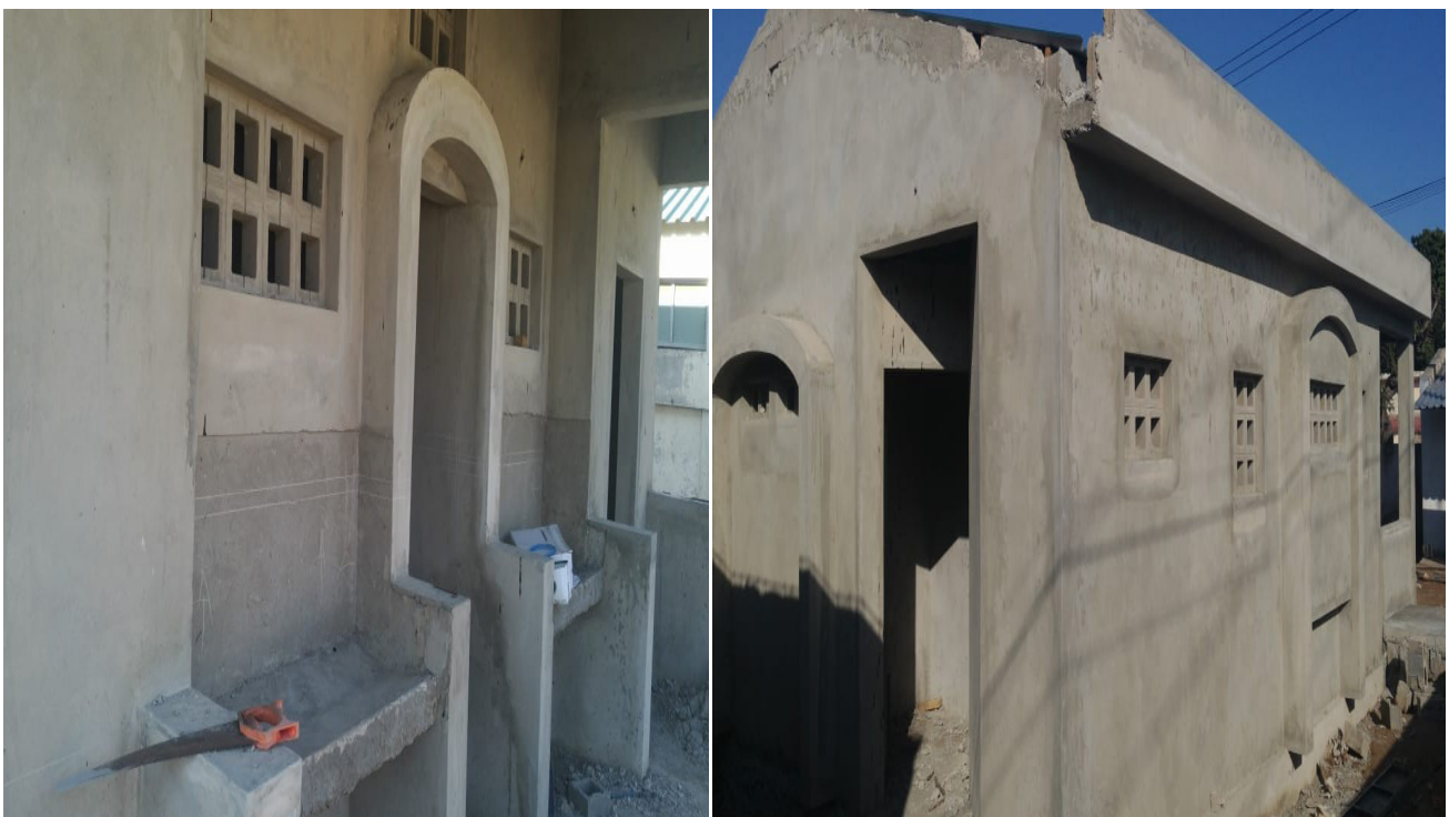
Figura 2: Sanitário em construção na Escola Secundária Acordos de Lusaka- Maxixe
