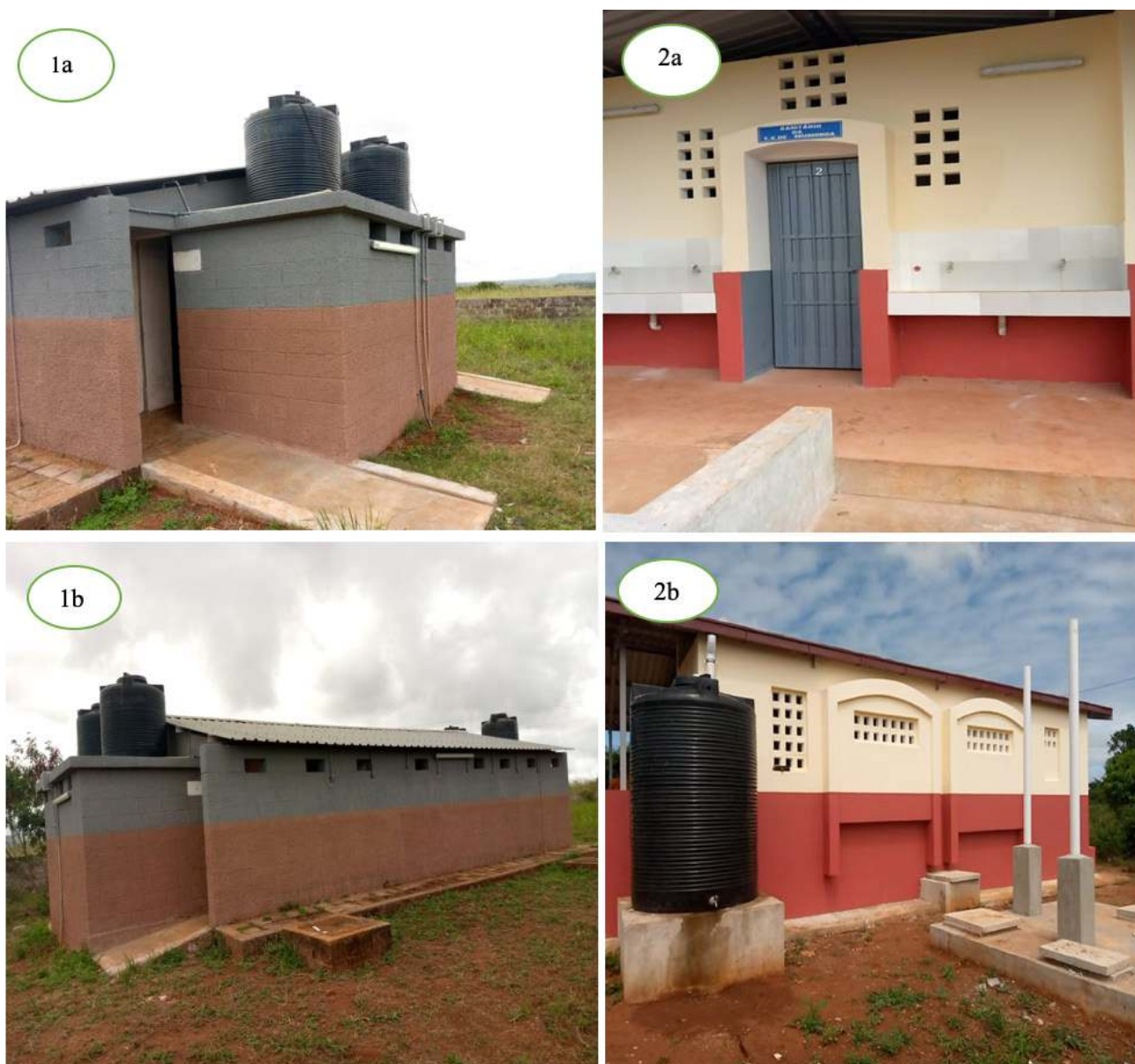
Figura 5: 1- Sanitário Escola Secundária de Sussundenga; 2- Sanitário Escola Secundária de Munhinga/ Província de Manica
