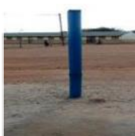
1 furo de água
