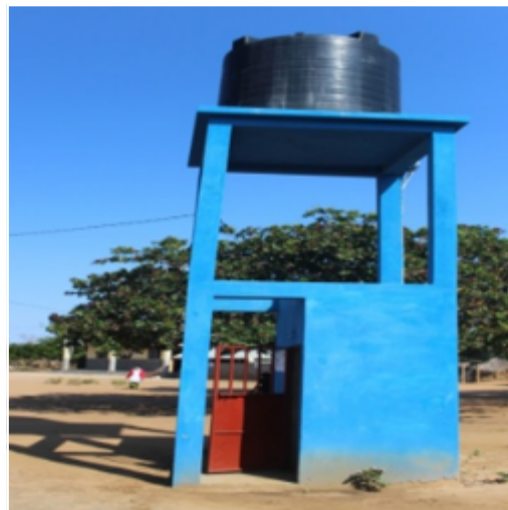
Furo de captação de água
