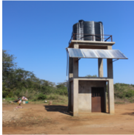
Pequeno Sistema de Abastecimento de Água
