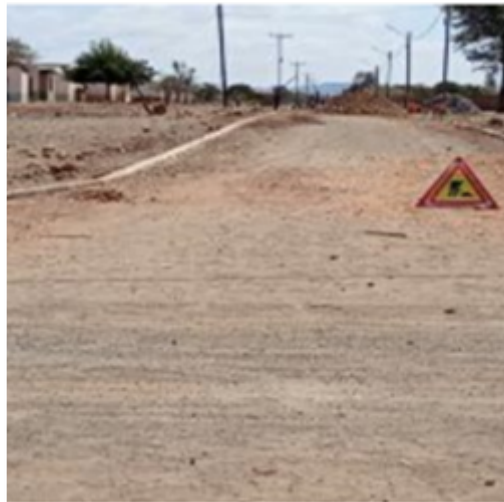
Estrada em pavimentação
