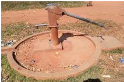
Imagem 3: furo de agua avariado
