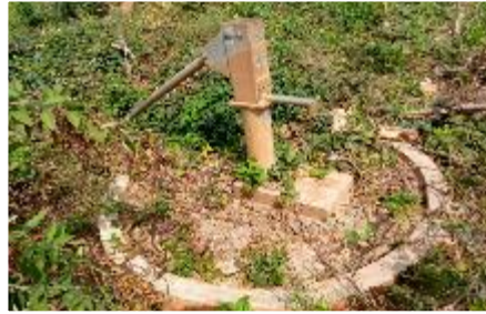
Imagem 4: furo de agua avariado
