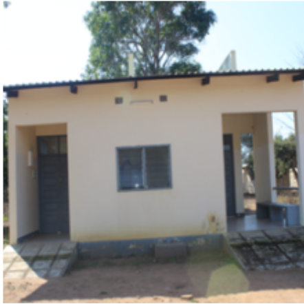
Pequeno Sistema de Abastecimento de Água
