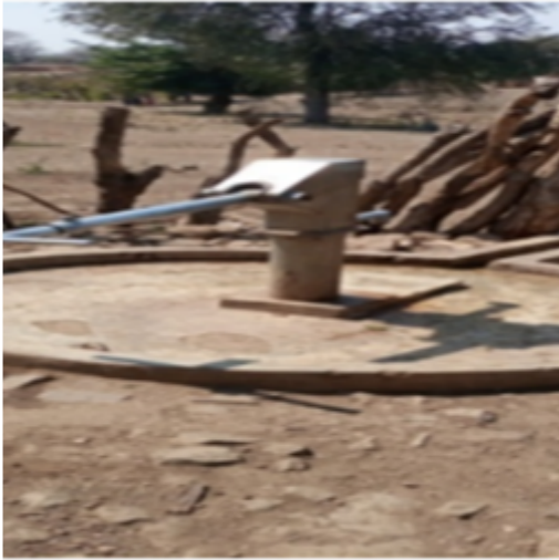
Bomba de agua não funcional
