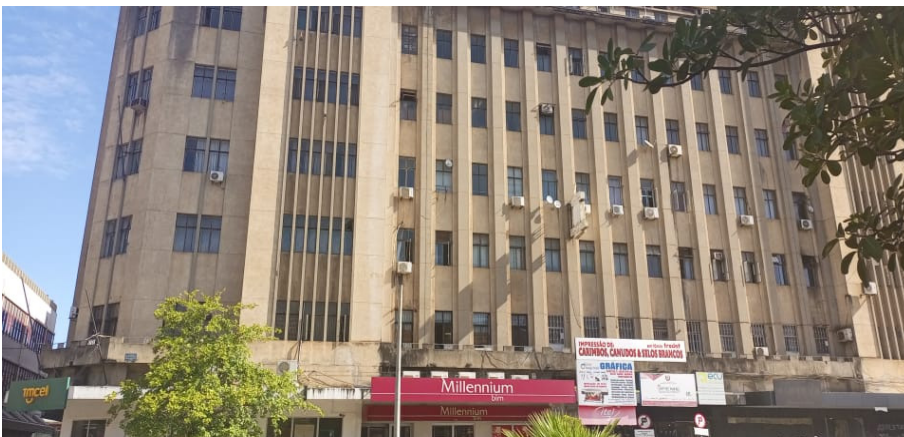
Prédio Continental. Av. 25 de Setembro – nº 1511 - Baixa da cidade de Maputo, onde estão localizados 20 apartamentos pertencentes à Empresa Correios de Moçambique.
