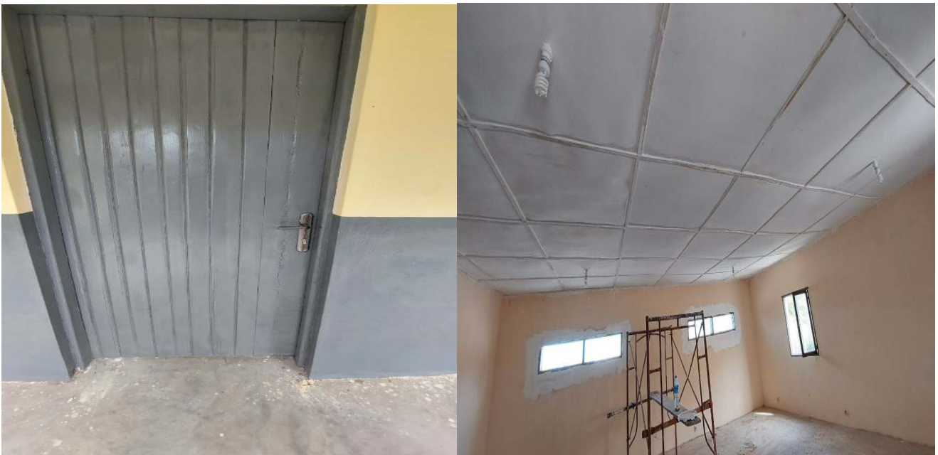
Imagem 41: Infraestruturas do centro de saúde da Chocas Mar
