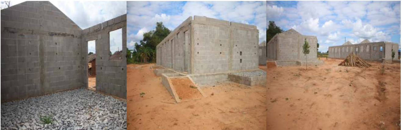
Imagem 3: Estágio das obras de construção de salas de aulas
