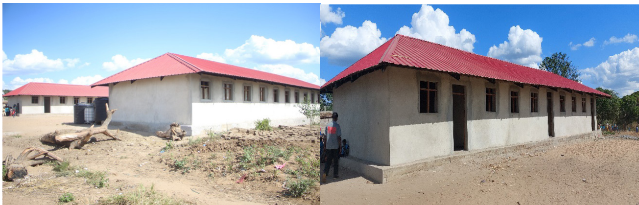
Imagem 24: Obras de salas de aulas paralizadas
