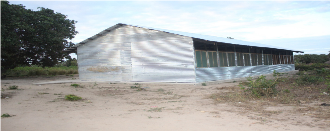
Imagem28: Salas de aulas em construção na EPC Mucuaracuane. Todas encontram-se abandonadas
