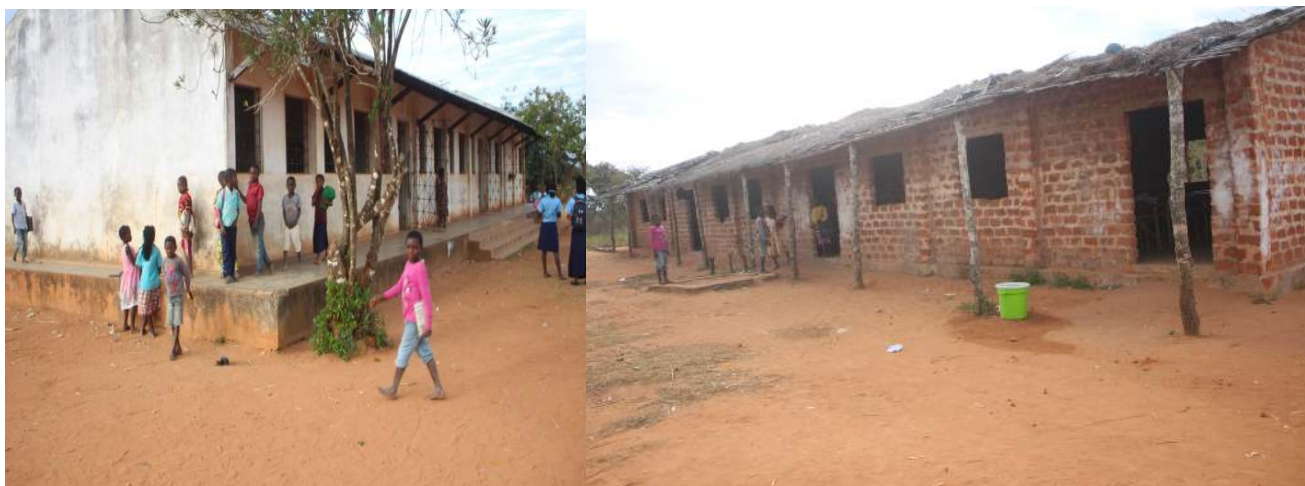
Imagem 15: Actuais salas de aulas onde se leccionam as aulas da Escola Secundaria de Cunle
