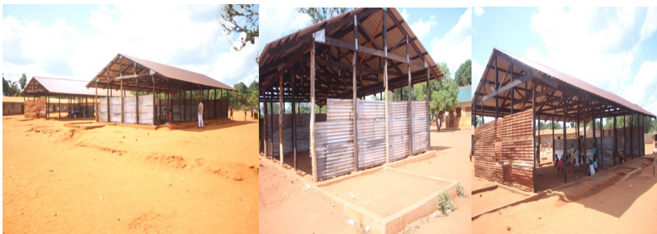
Imagem 21: Salas de aulas abandonadas pelo empreiteiro
