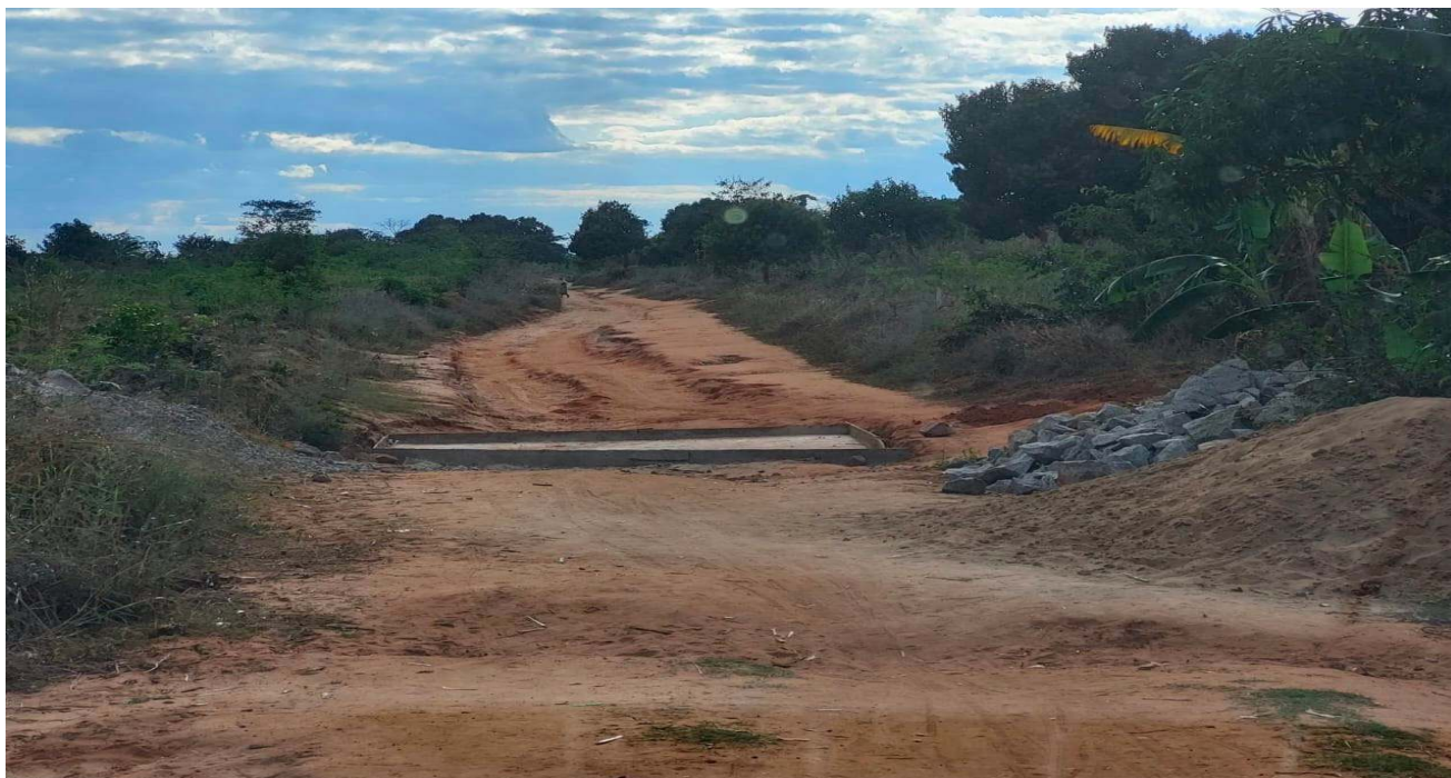
Imagem 34: Via de acesso ao centro de saúde em construção na localidade de Roieque
