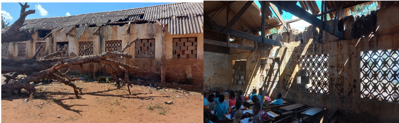
Imagem18: Salas de aulas usadas actualmente na EPC de Namialo
