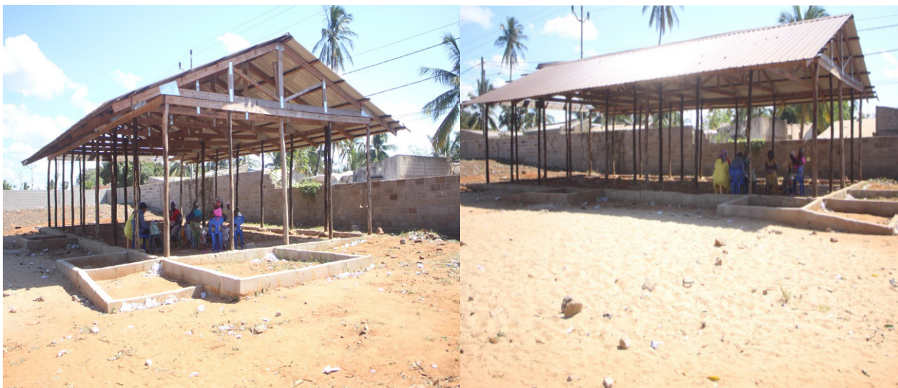
Imagem19: Salas de aulas construídas
