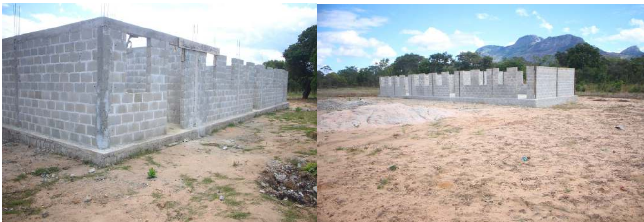
Imagem 5: Estágio das obras
