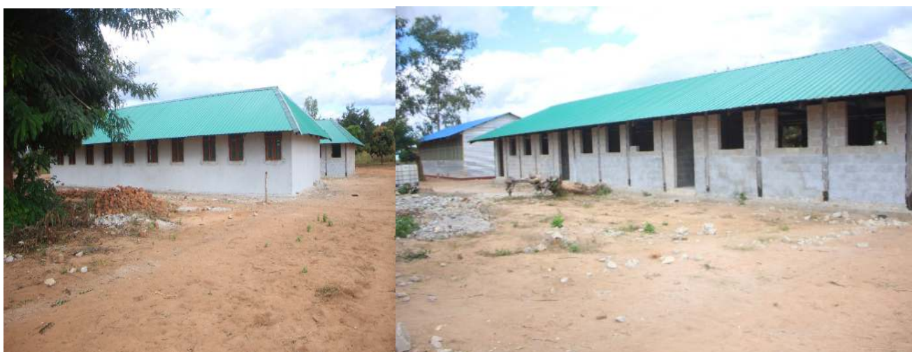
Imagem 11: Imagem do estágio das obras.
