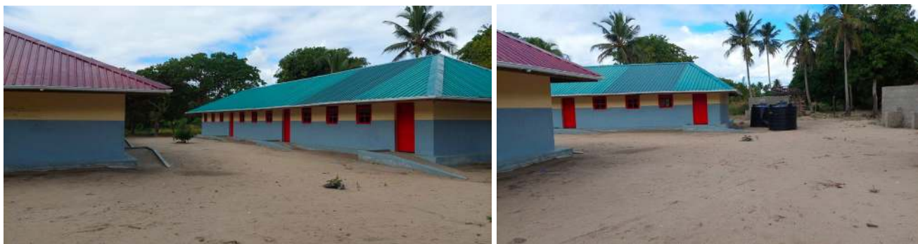
Imagem 33: Salas de aulas construídas da EPC de Manja
