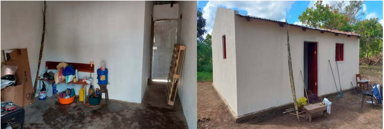
Imagem 50: Parte frontal e interior da residência dos técnicos do Posto de saúde de Conho
