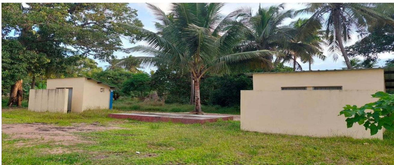
Imagem 62: Sanitários do posto de saúde de Magaua
