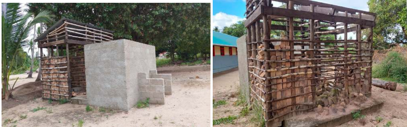
Imagem 34: Sanitários em construção na EPC de Manja
