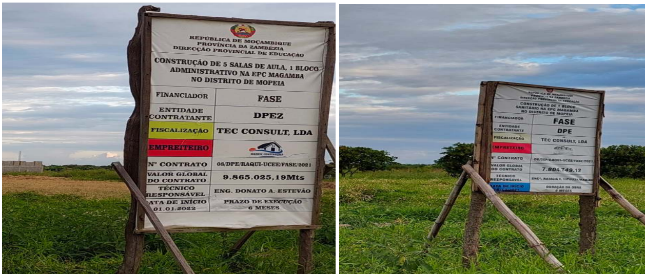
Imagem 7: Placas de construção de 5 salas de aulas e 1 bloco sanitário na EPC de Mutuo.
