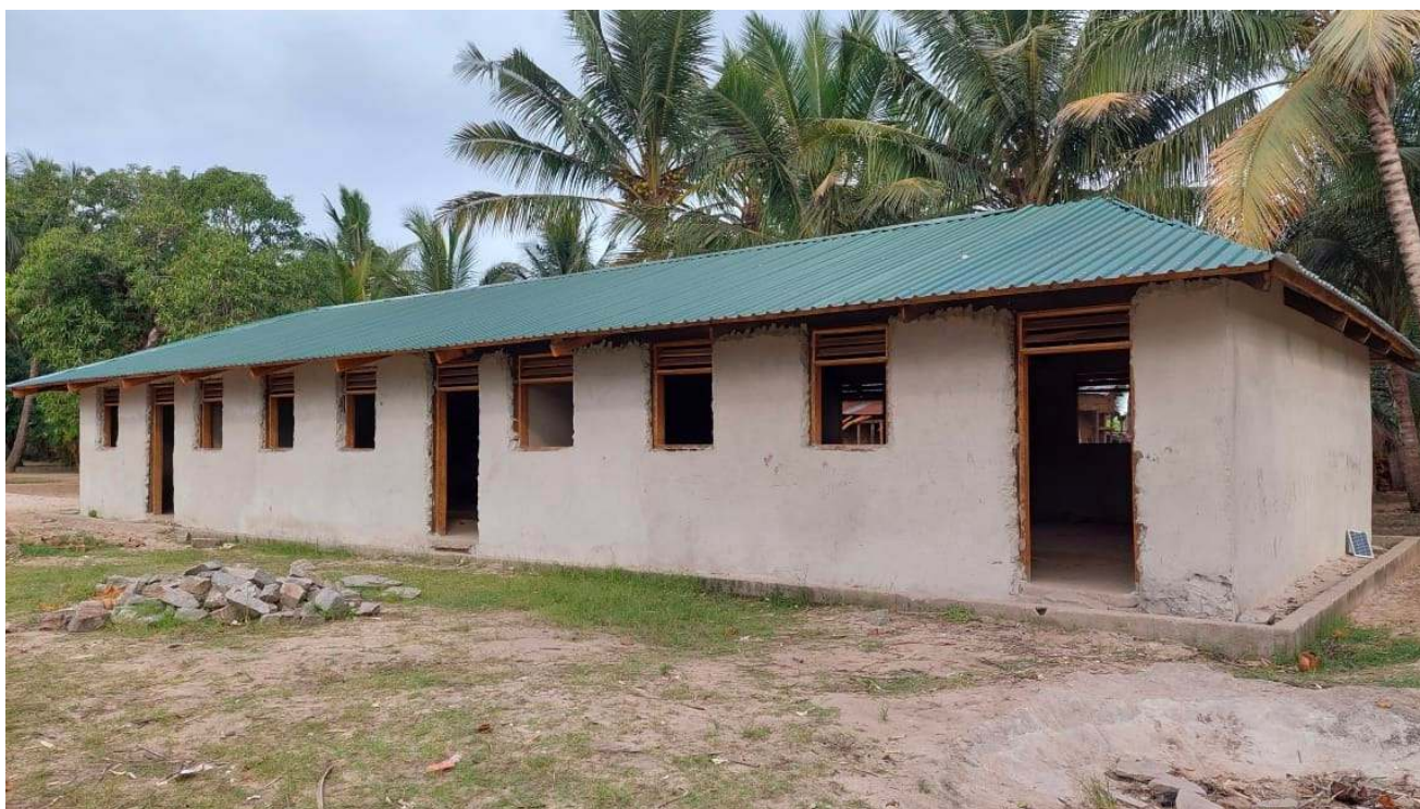
Imagem 35: salas de aulas construídas na EPC de Mitulane
