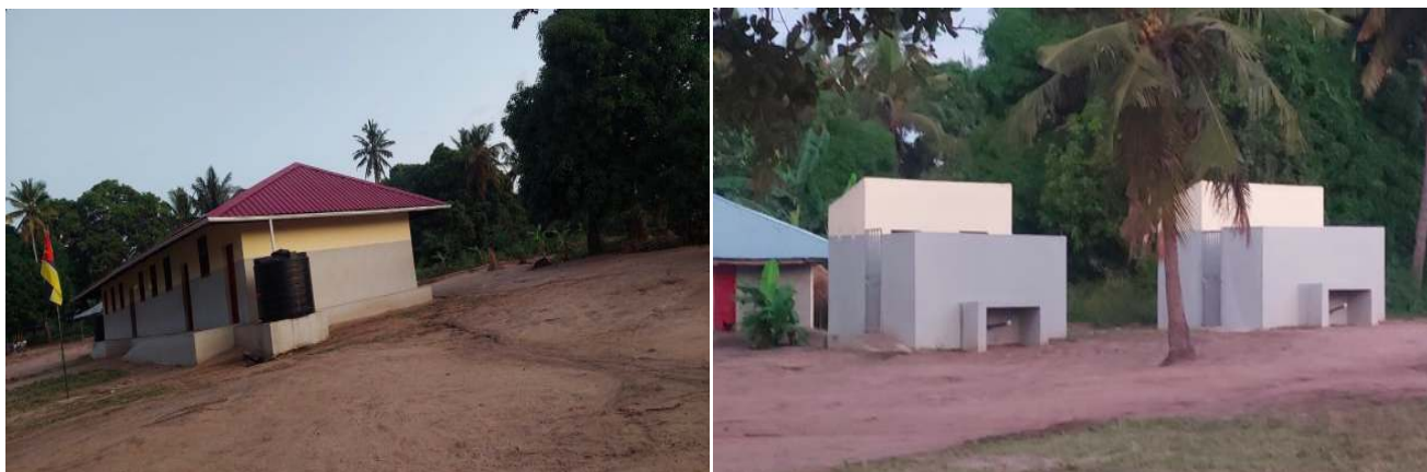
Imagem 16: salas de aulas construídas na EPC murranga e sanitários
