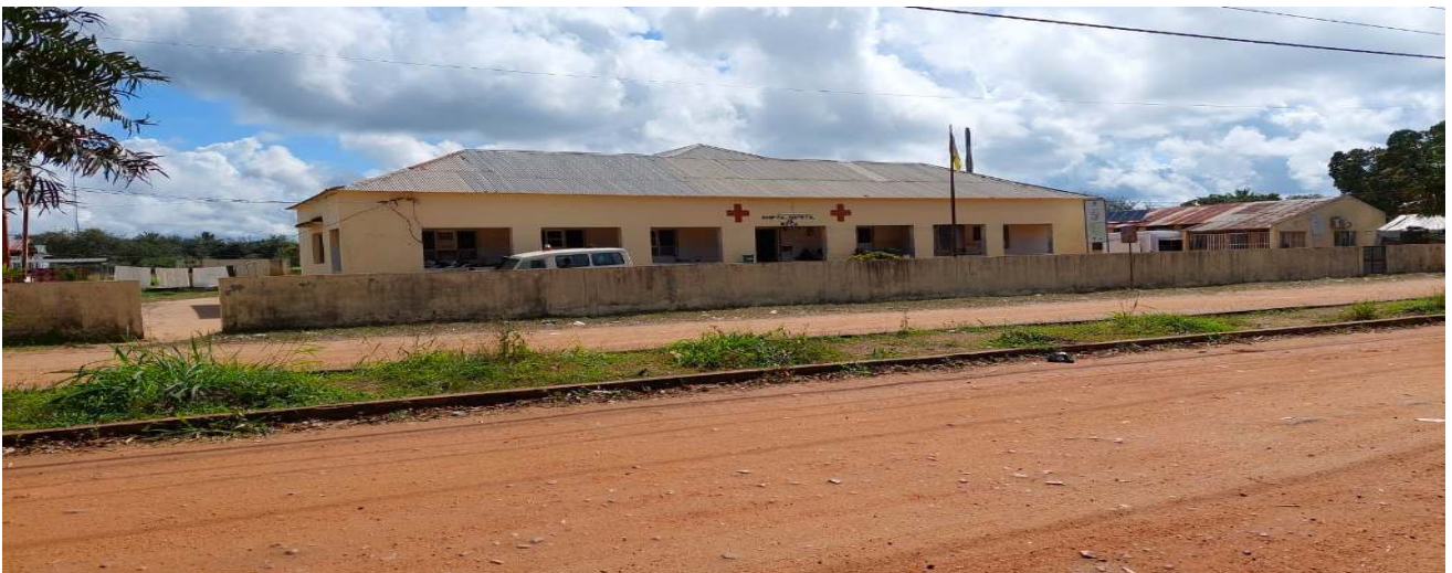
Imagem 41: Parte exterior do hospital distrital de Mopeia
