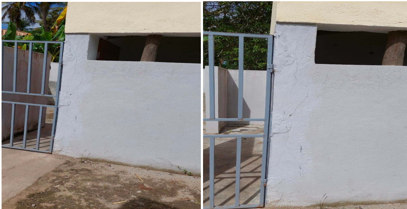
Imagem 32: Sanitários construídas na EPC de Munhalo
