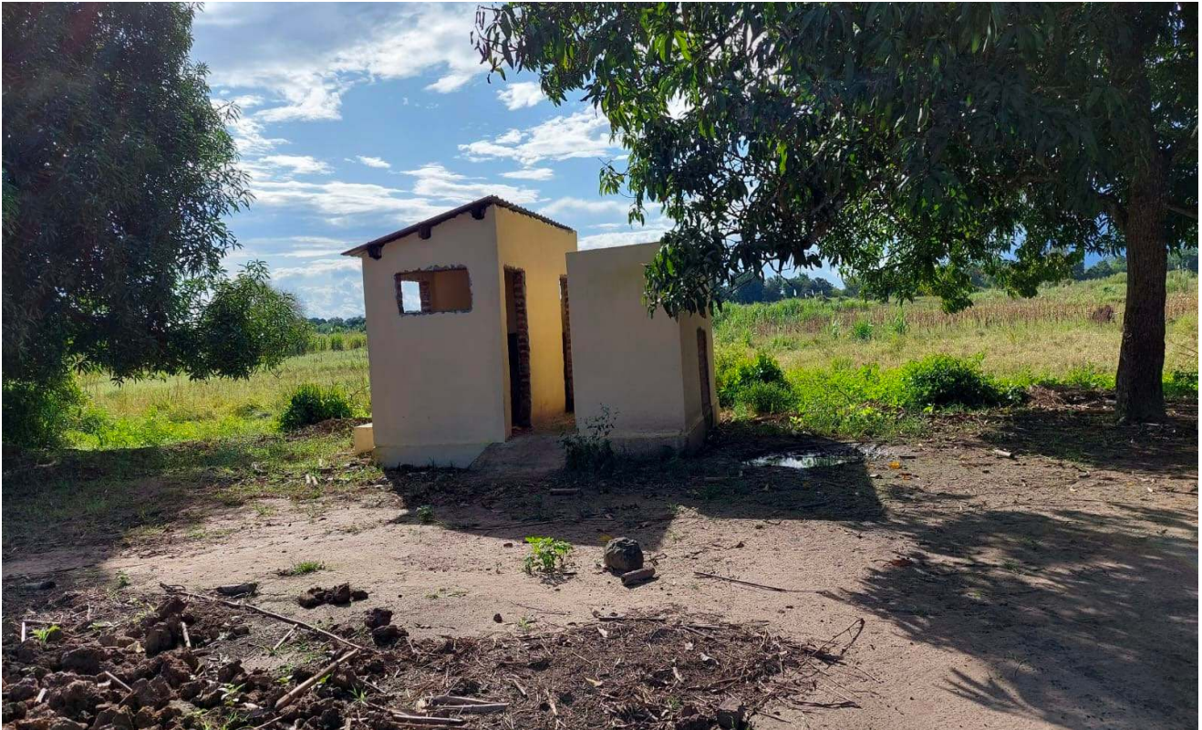
Imagem 3: Sanitários construídos na EPC magamba
