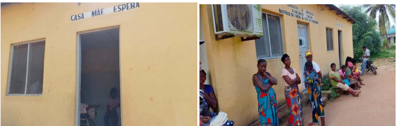
Imagem 43: Instalações da casa mãe-espera
