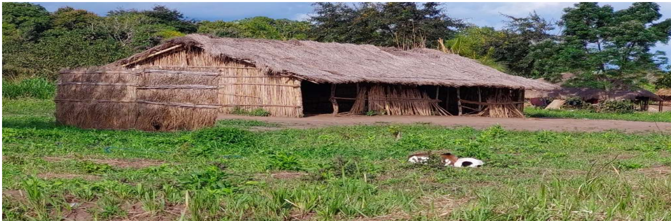
Imagem 6: Sala de aulas anexa da EPC Magamba e sanitário dos alunos
