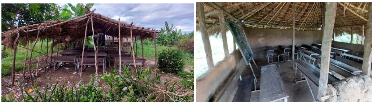
Imagem 10: Salas de aulas em uso na EPC 1 e 2 de Mutuo
