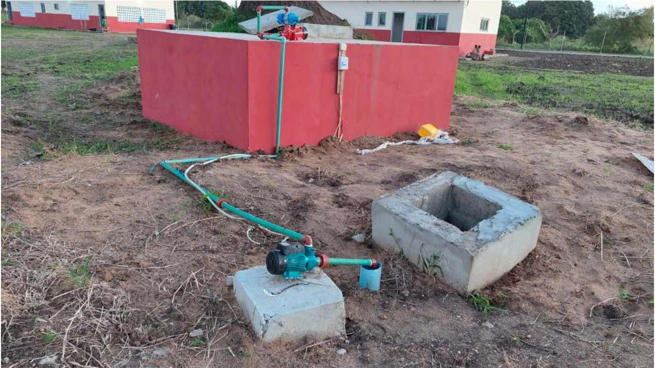
Imagem 39: Bomba de água construída no centro de saúde de Chimbazo
