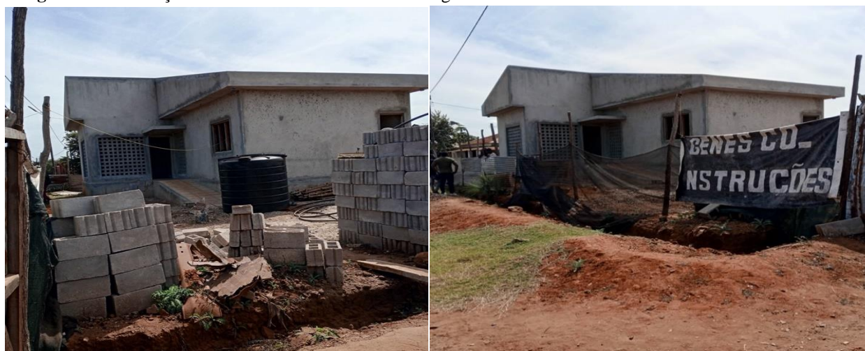
Imagem 13: Construção do sistema de abastecimento de água em Kambulatsitsi
