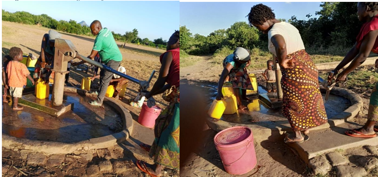
Imagem 5: Furos de água em funcionamento localidade de samoa
